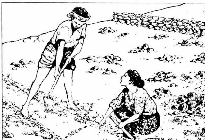
Hình 15. Tạo nền móng để xây dựng tường đá
