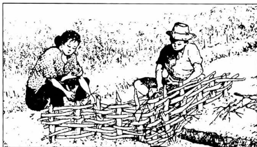
Hình 19. Xây dựng rào chắn
